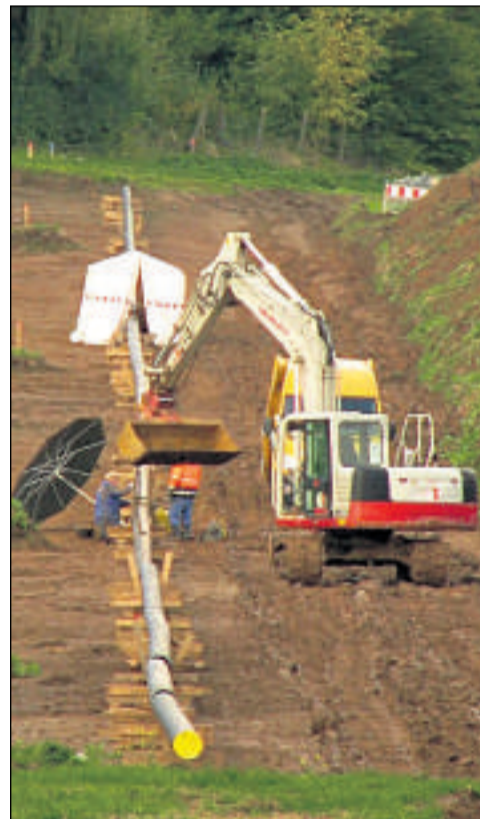
Lange Leitung: Hier wird am Rohrstrang in Richtung Holzbürgel gebaut.
